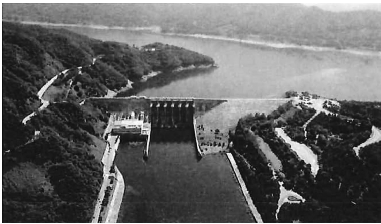
大淸ダム：向かって左側がコンクリートダム、右側がロックフィルダム、中央で一体化している。発電量は9万kw
