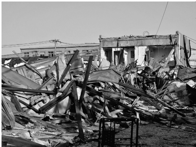
取り壊し直後の現場、2017年12月
