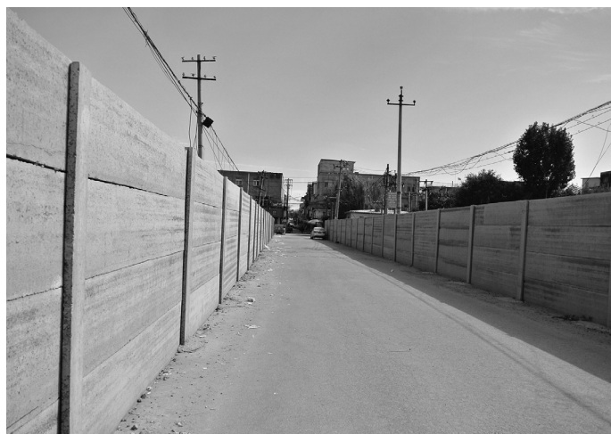
コンクリート塀で隔された取り壊し現場、2018年8月（以下同日）
