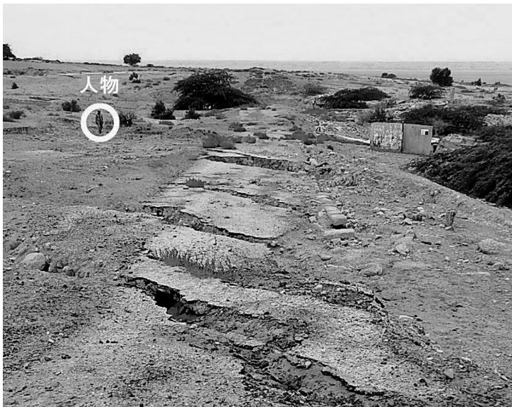
写真4：死海湖岸の陥没。湖面低下とともに湖岸の陥没が起こっている
