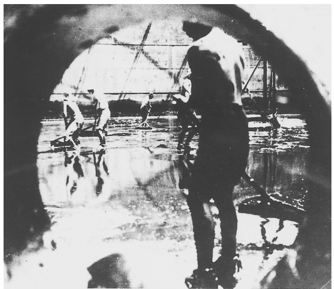
タンク底油の回収作業
